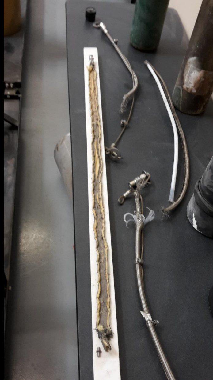
feu propagé à la tuyauterie
